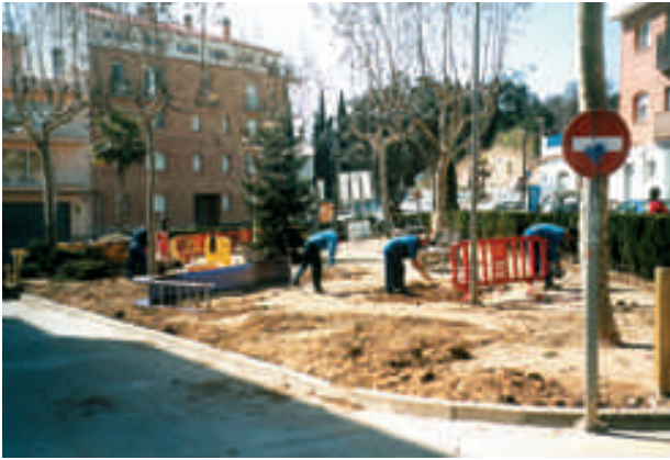
Rehabilitació de la plaça Pau Casals.
