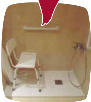
Substitució de banyera per plat de dutxa.
