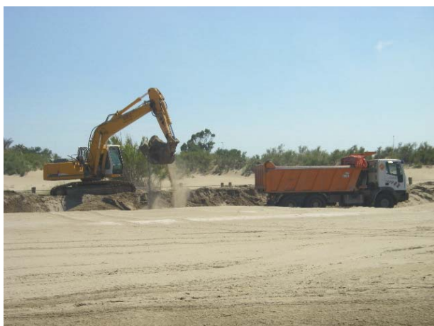
Obres a la platja de Riumar, a Deltebre (23-06-2010)
