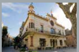
Rehabilitació paviment Biblioteca
