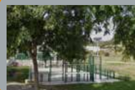
Instal·lació pista multiesportiva
