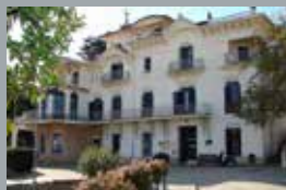
Rehabilitació de l'edifici de Vil·la Flora
