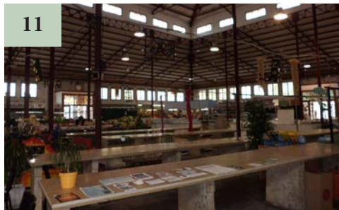
11 REFORMA I REHABILITACIÓ DE L'INTERIOR DE LA PLAÇA MERCAT
