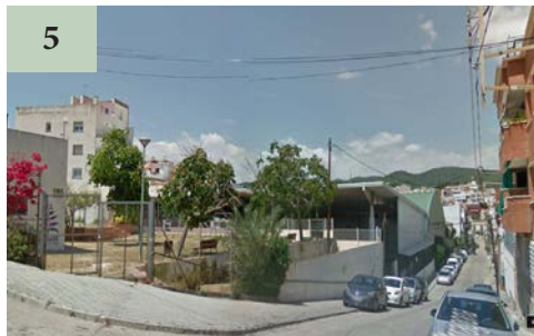
5 ADEQUACIÓ DE LA PISTA D'HOQUEI
