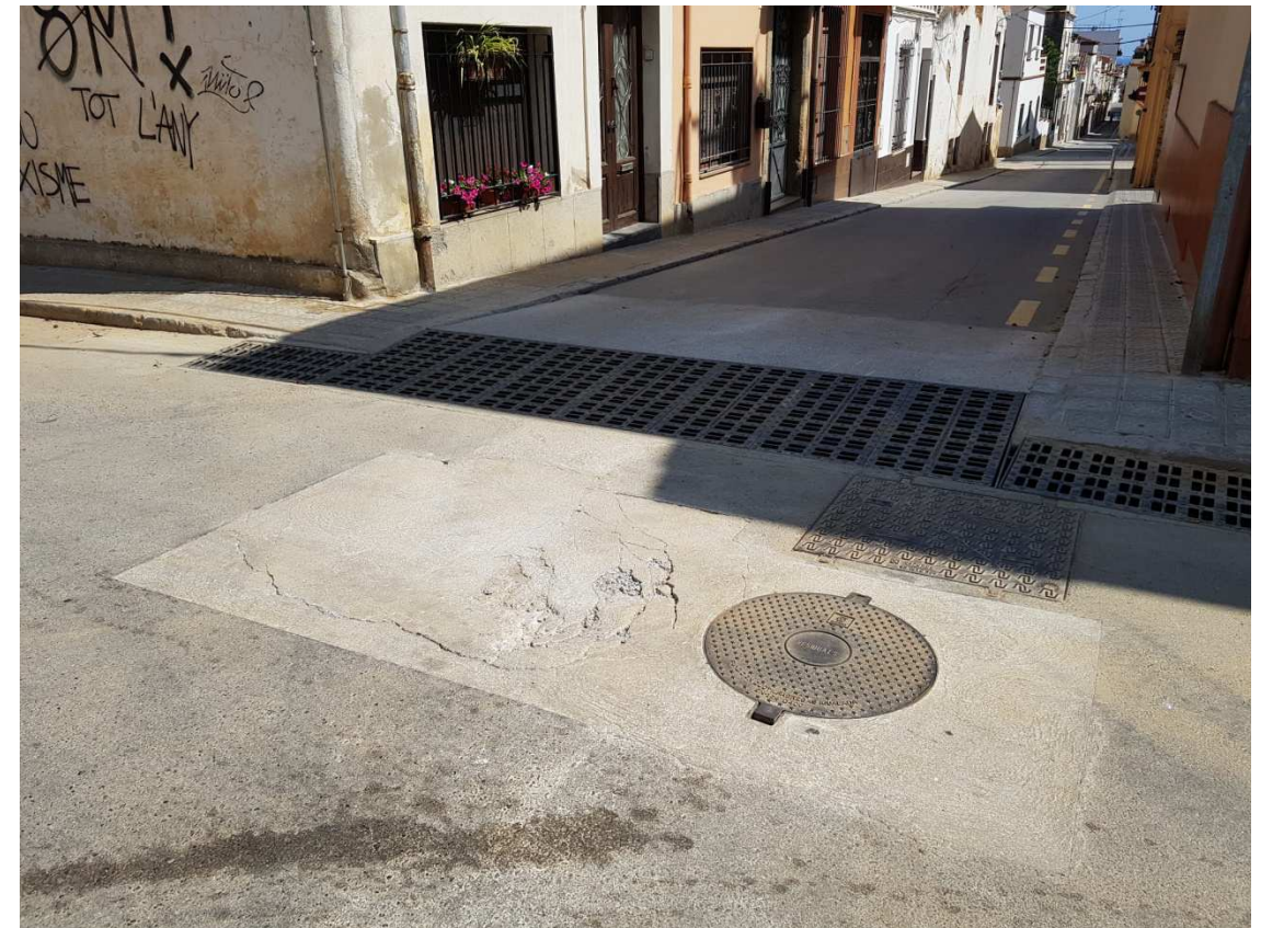
Imatge 5 Cruïlla del Carrer Josep Móra i el carrer Abell Baix. En primer terme es veu un pou nou de la xarxa de residuals i a continuació una reixa interceptora que caldrà conduir a la nova canalització de pluvials i desconnectar de la xarxa de residuals
