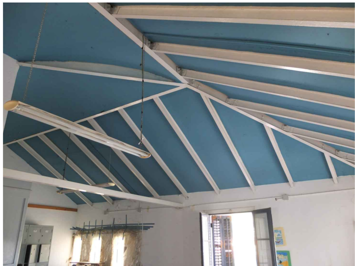
V10. Les biguetes transversals formen el pla inclinat de la coberta del sector F. Les bigues principals marquen el canvi a coberta plana del sector E, i el sostre és de volta. Font: GAA. 02/10/2018
