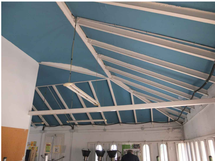
V4. Bigues principals disposades diagonalment i al perímetre de la coberta inclinada del sector F per formar el carener. Les biguetes transversals son perfils metàl·lics IPN o IPE. Font: GAA. 02/10/2018
