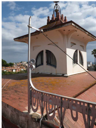
V2. Vista del voladiu de la coberta de la torre. Font: GAA. 25/09/2018
