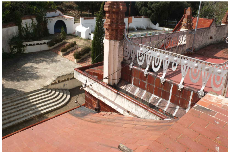
V4. Sortida d'aigües pluvials de la coberta plana del sector E cap a la canal del ràfec perimetral del sector F. Font: GAA. 25/09/2018
