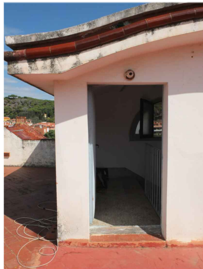
V4. Vista de la sortida a coberta. Parament sud-oest. Font: GAA. 25/09/2018
