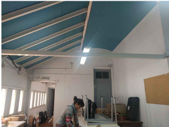
V6. Les biguetes transversals formen el pla inclinat de la coberta del sector F. La biga principal longitudinal marca el canvi a coberta plana del sector E, i el sostre és de volta. Font: GAA. 02/10/2018
