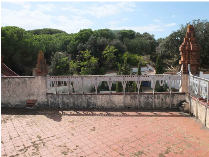
V8. Vista del paviment ceràmic de dimensions 13x13 cm, disposat a 45°. Font: GAA. 25/09/2018
