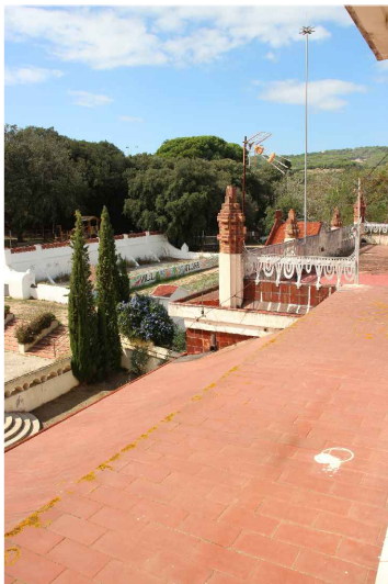
V11. Vista del pas perimetral del voltant de la torre. Font: GAA. 25/09/2018
