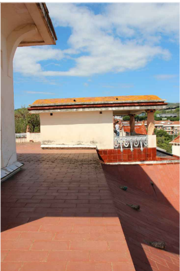
V5. Coberta de l'entron de la torre de peces ceràmiques de 14x28 cm. Font: GAA. 25/09/2018
