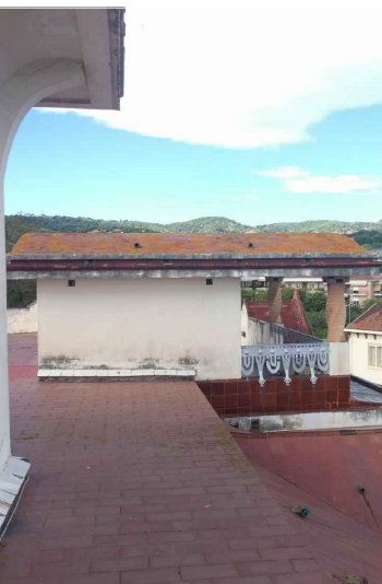
V4. Vista de la coberta plana del sector E i de la coberta inclinada del sector F.
