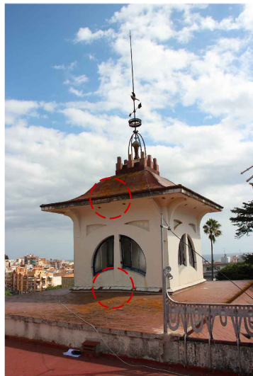
V1. Presència de líquens, taques d'humitat i brutícia. Font: GAA. 25/09/2018
