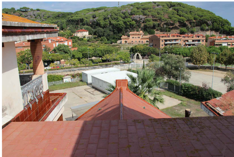
V6. Vista de la coberta plana de l'entorn a la torre i de la coberta inclinada del sector F. Font: GAA. 25/09/2018
