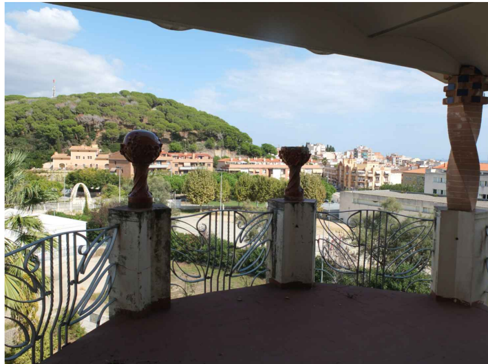
V4. Vista de la barana de la porxada de la glorieta, combina elements de fosa i paraments d'obra. Font: GAA. 25/09/2018
