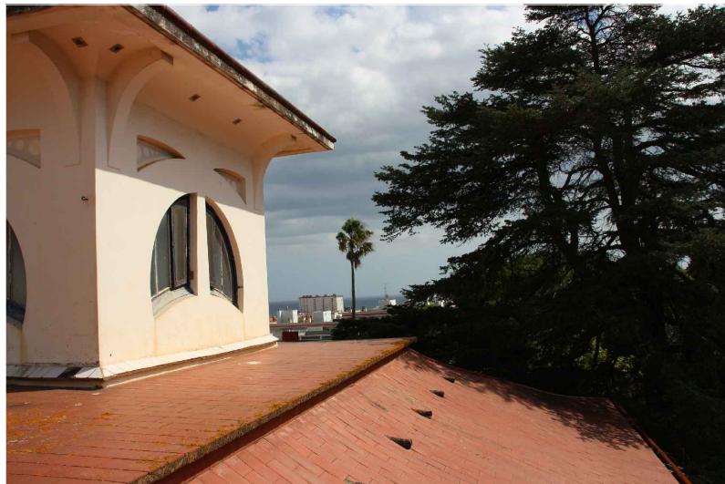
V1. Vista de la coberta inclinada del sector F. Font: GAA. 25/09/2018
