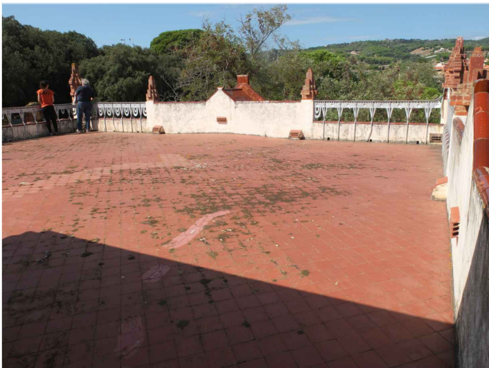
V3. Vista del parament nord-oest. Font: GAA. 25/09/2018
