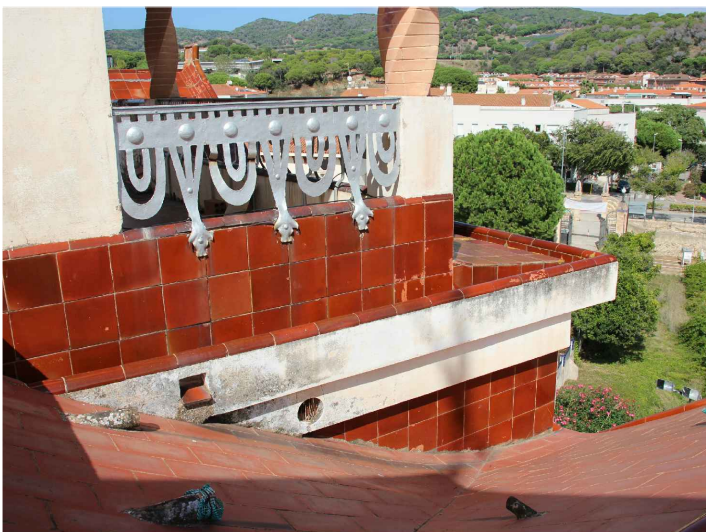
V13. Detall de sortida d'aigua de l'espai sota la porxada del badalot d'escala. Font: GAA. 25/09/2018
