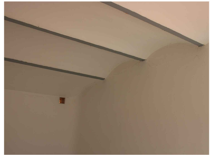
V11. Vista de l'estructura de la coberta del badalot, amb biguetes d'acer de base 6 cm i revoltó ceràmic. Font: GAA. 25/09/2018
