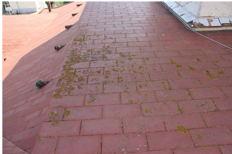
V7. Detall del paviment de rajola ceràmica de 14x28 cm col·locat a trencajunt. Font: GAA. 25/09/2018
