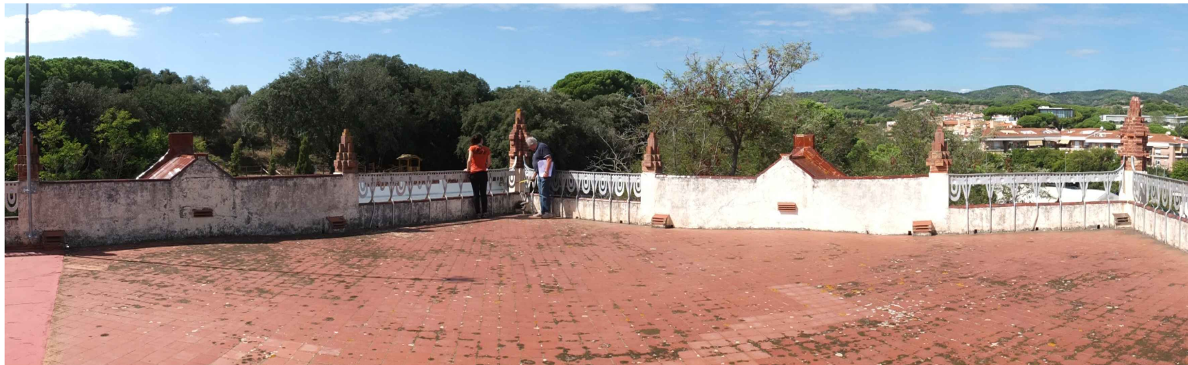
V5. Vista dels paraments nord-oest i sud-oest de la coberta plana del sector A . Els paraments verticals combinen barana d'obra i barana de fosa, entre els quals trobem pinacles cantoners i centrals. Font: GAA. 25/09/2018
