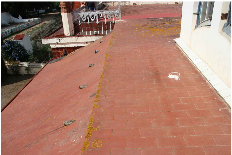
V12. Vista de la coberta plana de l'entorn a la torre i de la coberta inclinada del sector F. Font: GAA. 25/09/2018
