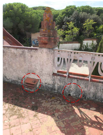
V11. Taques de brutícia i humitats. Presència de fongs en paraments verticals. Font: GAA. 25/09/2018
