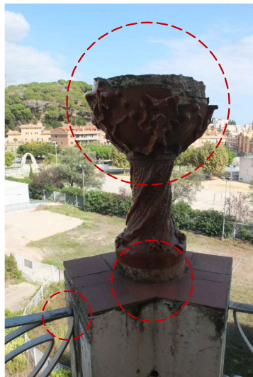
V10. Despreniment de material. Taques d'humitat i brutícia. Font: GAA. 25/09/2018
