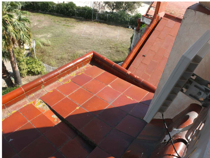
V1. Detall de canal perimetral i sortides d'aigua cap a la canal. Font: GAA. 25/09/2018
