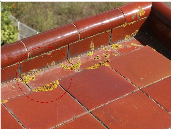
V3. Degradació de les peces ceràmiques vitrificades. Envelliment. Presència de líquens en la superfície. Font: GAA. 25/09/2018
