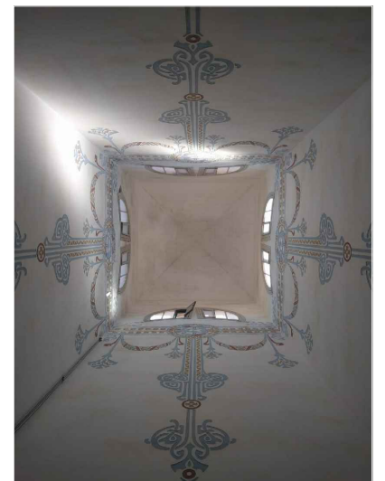
V13. Vista zenital de l'interior del volum de la torre. Font: GAA. 02/10/2018
