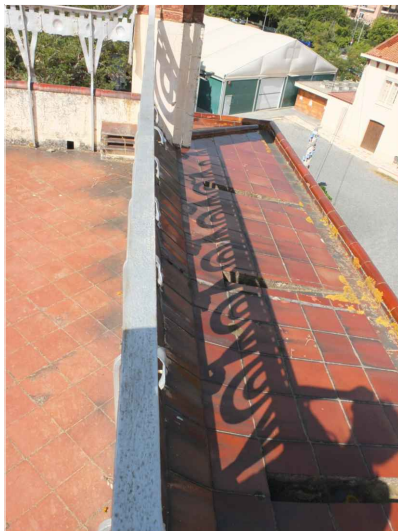
V7. Sortides d'aigua procedents de la coberta plana, cap a la canal perimetral. Font: GAA. 25/09/2018
