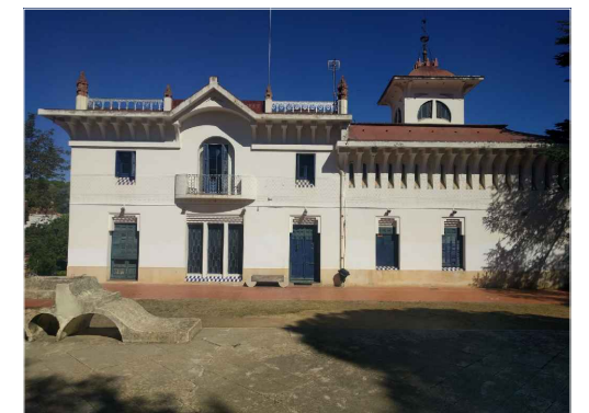
V2. Façana posterior. Orientació sud-oest. Font: GAA. 02/10/2018
