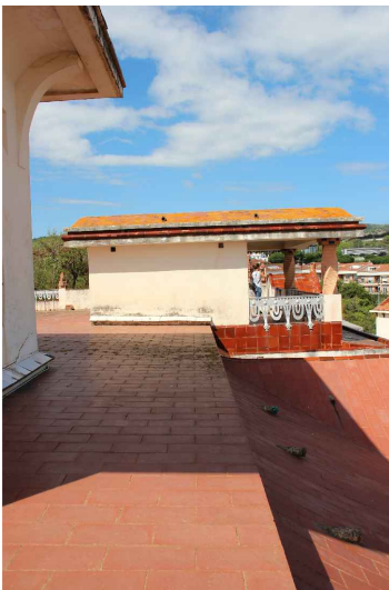
V5. Trobada entre la coberta del sector E i la del sector F. Font: GAA. 25/09/2018
