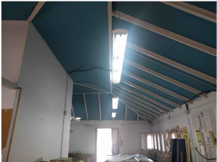
V8. Les biguetes transversals formen el pla inclinat de la coberta del sector F. La biga principal longitudinal marca el canvi a coberta plana del sector E, i el sostre és de volta. Font: GAA. 02/10/2018
