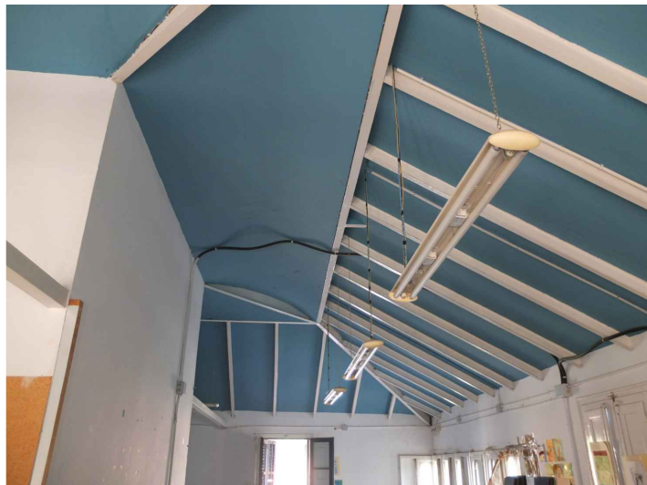
V9. Les biguetes transversals formen el pla inclinat de la coberta del sector F. La biga principal longitudinal marca el canvi a coberta plana del sector E, i el sostre és de volta. Font: GAA. 02/10/2018
