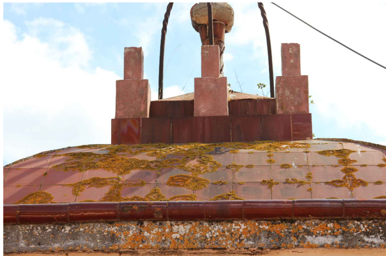
V5. Detall de la volta de la coberta de la torre i de la seva trobada amb el l'element de coronació. Volta sobre envanets de sostremort. Font: GAA. 25/09/2018
