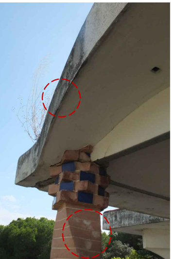
V13. Eflorescències en pilars ceràmics. Taques d'humitat i de brutícia. Font: GAA. 25/09/2018
