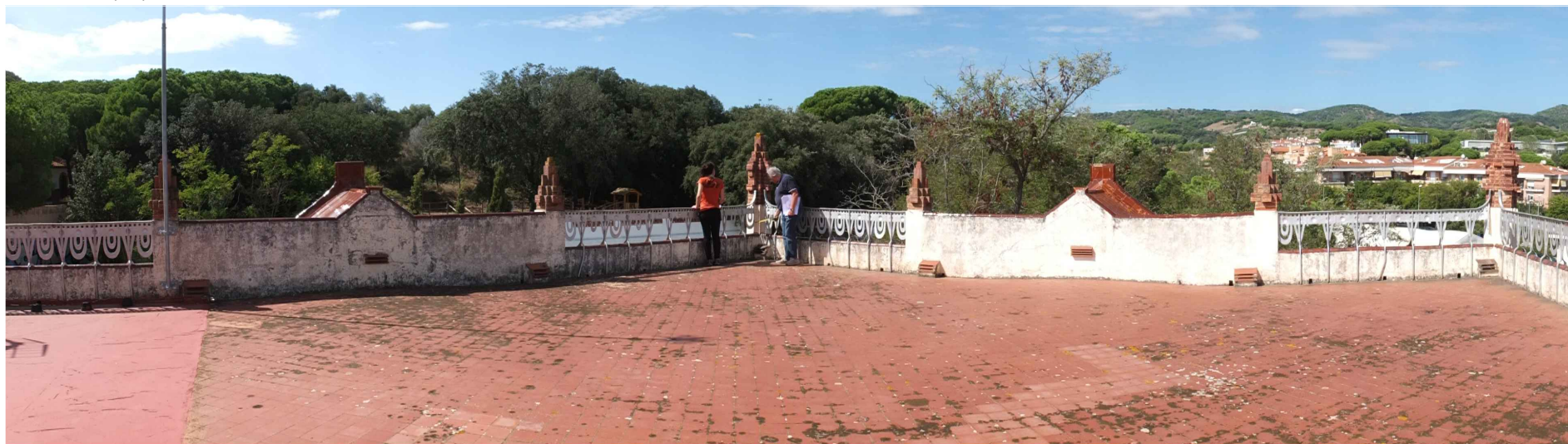
V2. Vista dels paraments nord-oest i sud-oest de la coberta plana del sector A. Els paraments verticals combinen barana d'obra i barana de fosa, entre els quals trobem pinacles cantoners i centrals.
