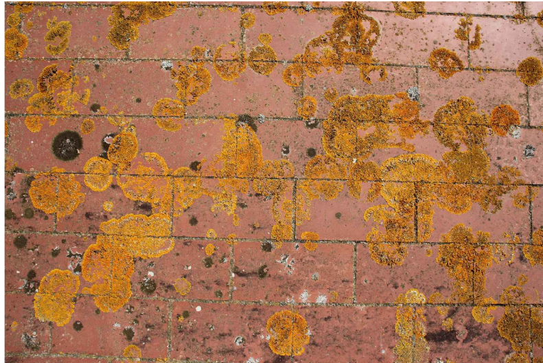
V8. Degradació de les juntes i presència generalitzada d'eflorescència i líquens a les juntes i a la superfície del paviment de rajola ceràmica. Taques de brutícia i d'humitat. Font: GAA. 25/09/2018
