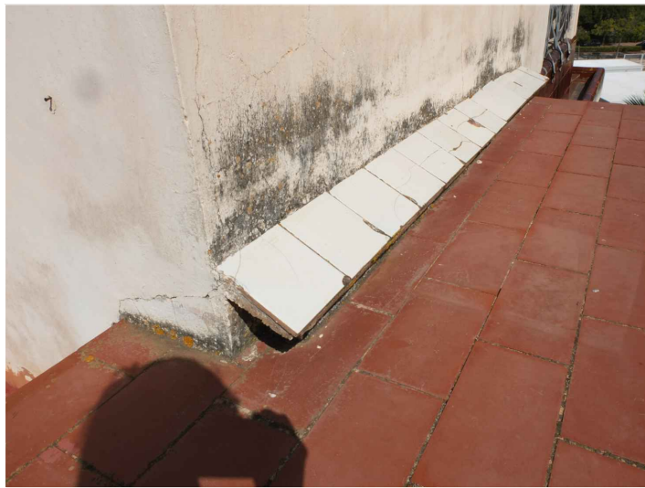
V9. Detall del minvell ceràmic vitrificat del parament sud-est. Font: GAA. 25/09/2018
