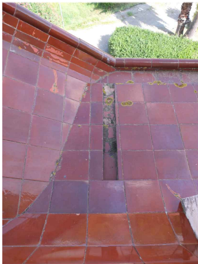
V4. Detall de trobada entre el pla horitzontal i el pla inclinat. Font: GAA. 25/09/2018
