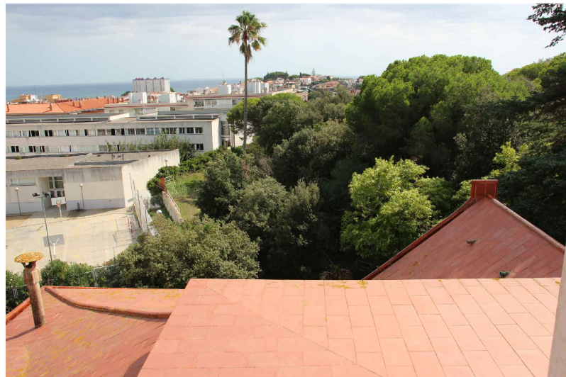
V7. Vista de la coberta plana de l'entorn a la torre i de la coberta inclinada del sector F. Font: GAA. 25/09/2018
