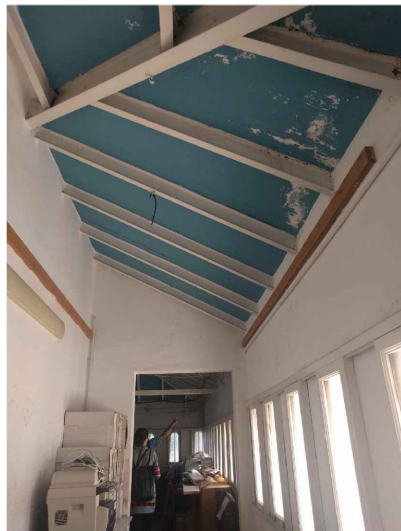
V1. Biga principal en diagonal forma el carener. Biguetes transversals. Font: GAA. 02/10/2018
