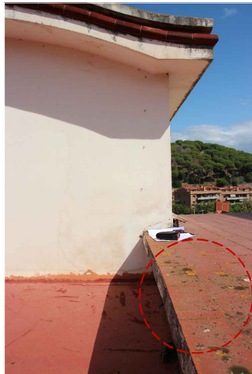
V5. Presència de líquens, taques d'humitat i brutícia. Font: GAA. 25/09/2018
