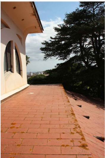
V4. Coberta de l'entron de la torre de peces ceràmiques de 14x28 cm. Font: GAA. 25/09/2018
