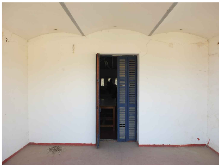
V9. Vista de l'estructura de la coberta de la porxada del sector G, formada per biguetes d'acer i entrebigat de volta. Obertura de la porta d'accés desde la segona planta. Font: GAA. 25/09/2018
