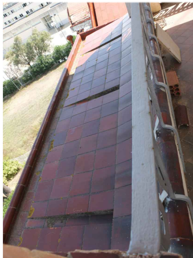
V2. Revestiment del ràfec perimetral de peça ceràmica de 18x18 cm. Font: GAA. 25/09/2018
