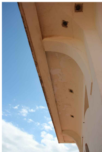
V8. Detall de la ventilació de la coberta de la torre. Font: GAA. 25/09/2018
