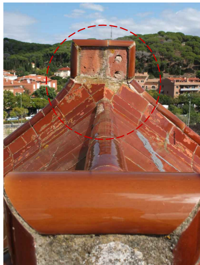
V10. Degradació i despreniment de peces ceràmiques vitrificades. Font: GAA. 25/09/2018
