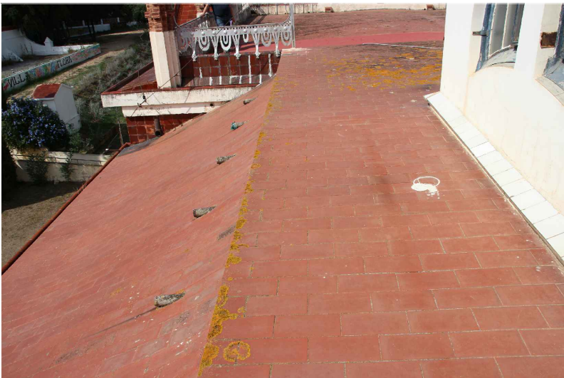
V2. Vista des de la coberta plana de l'entorn a la torre cap a la coberta inclinada del sector F. Font: GAA. 25/09/2018
