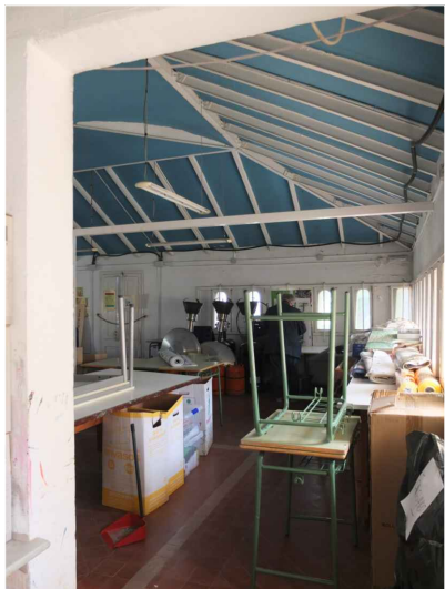
V3. Bigues principals en diagonal i al perímetre de la coberta inclinada per formar el carener. Font: GAA. 02/10/2018
