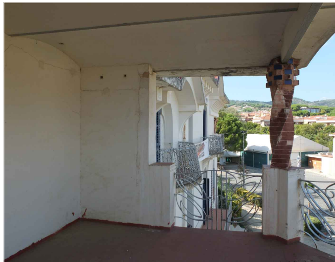
V3. Vista dels paraments de façana cap a l'espai de la porxada. Font: GAA. 25/09/2018
