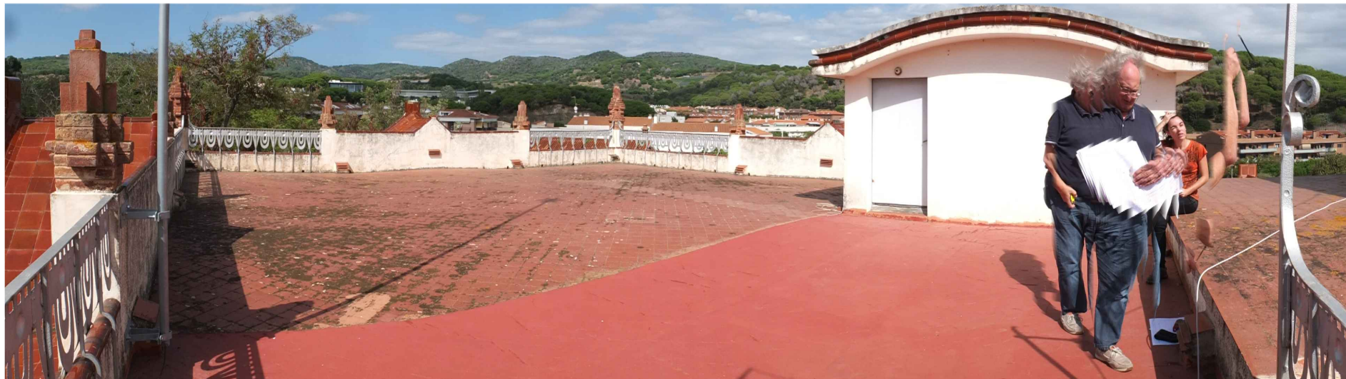
V1. Vista de la coberta plana del sector A i del badalot d'escala del sector C, davant d'aquest últim s'aprecia un canvi en el tractament del paviment, ha estat reparat amb un tela i una pintura impermeabilitzants. També s'observa el canvi de nivell entre el sector A i el sector E.
