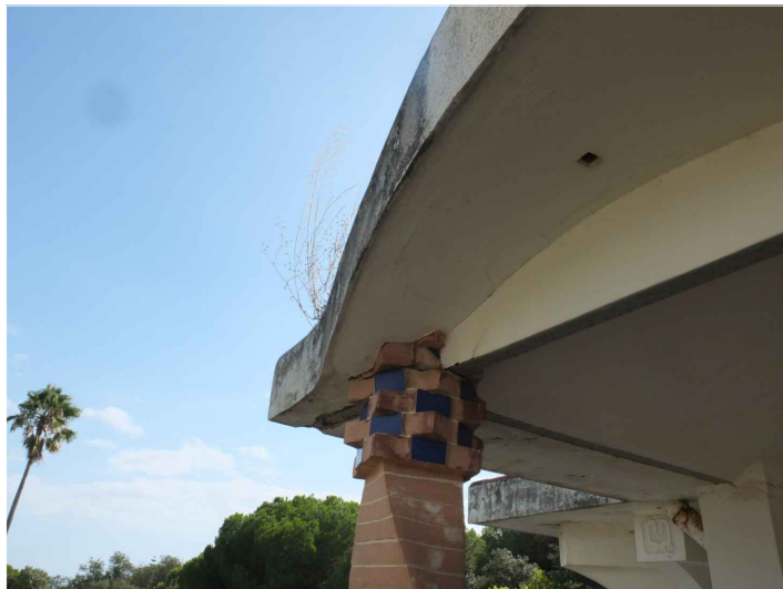
V2. Vista de la trobada entre la columna salomònica i l'estructura de bigues d'acer de la coberta del porxo. Font: GAA. 25/09/2018
