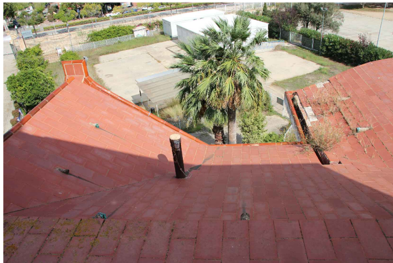
V7. Trobada entre la coberta inclinada del sector F i la coberta del porxo de la glorieta del sector G. Font: GAA. 25/09/2018
