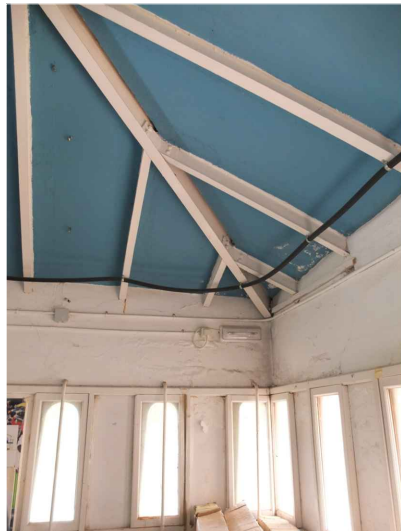
V5. Vista detall de la unió mecànica de les biguetes transversals a la biga principal. Font: GAA. 02/10/2018
