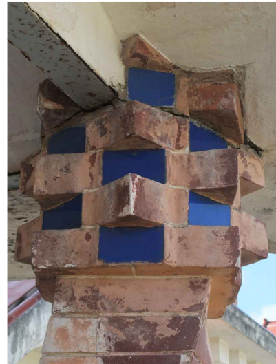
V7. Detall superior del capitell del pilar, que suporta l'estructura de la coberta del porxo. Font: GAA. 25/09/2018
