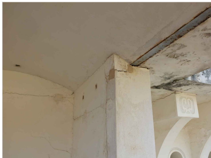
V10. Detall de la bigueta d'acer de base 7 cm de l'estructura de suport de la coberta de la porxada del sector G. Font: GAA. 25/09/2018
