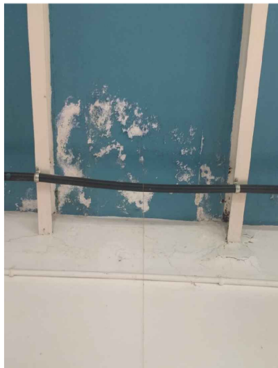
V2. Vista detall entrega biguetes metàl·liques transversals a façana. Font: GAA. 02/10/2018
