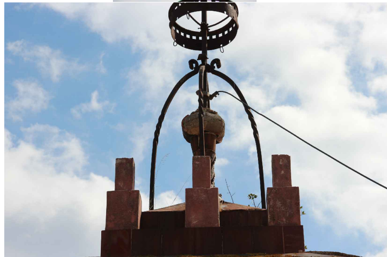
V6. Detall del pinacle central de ceràmica i acer com a element de coronació de la coberta de la torre. Penell i veleta del parallamps. Font: GAA. 25/09/2018
