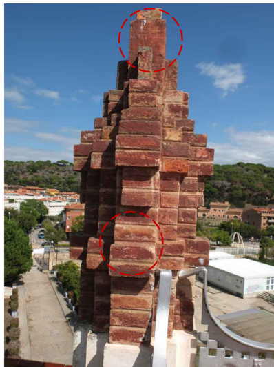
V9. Presència generalitzada d'eflorescències i líquens Font: GAA. 25/09/2018
