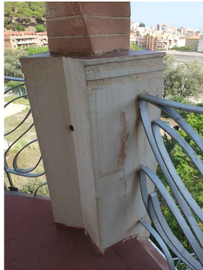
V6. Detall de l'ancoratge de la barana de fosa al parament d'obra. Font: GAA. 25/09/2018
