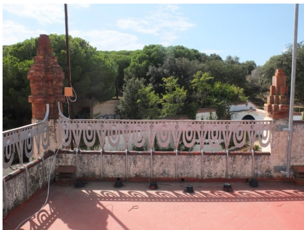
SECTOR A. Coberta plana principal. Font: GAA 25/09/2018
