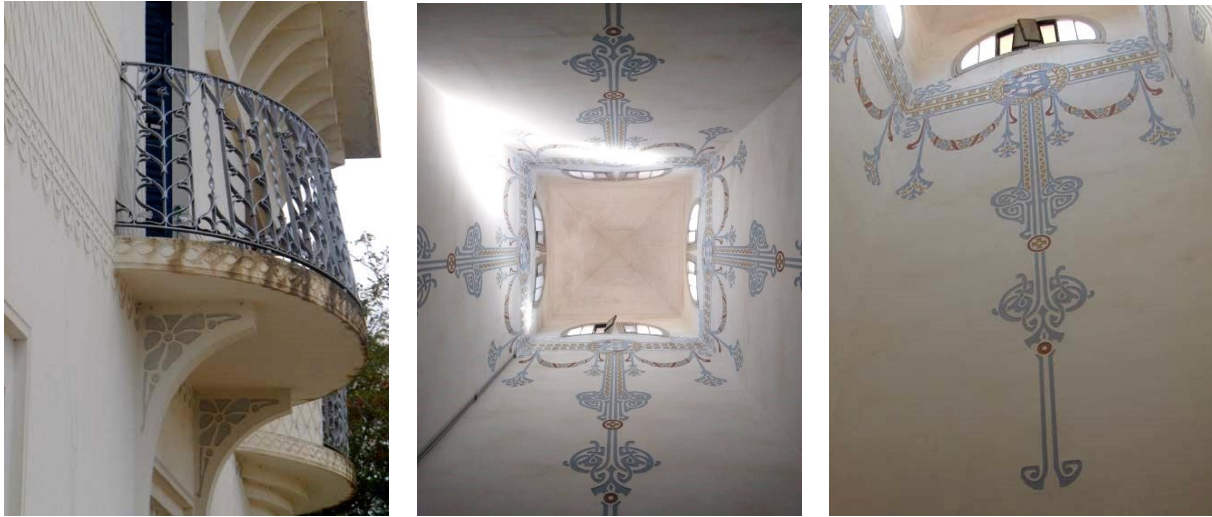
Imatges de les baranes de ferro forjat de planta primera i dels esgrafiats i estucats planxats de l'interior de la torre.
