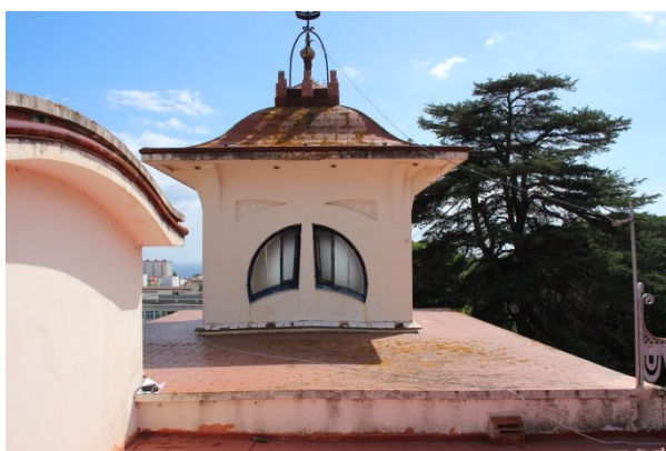
SECTOR E. Coberta plana (entorn torre).
