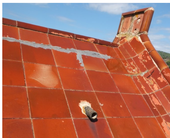
Imatges dels diferents danys, lesions i degradacions que es troben al ràfec perimetral (sector B).
