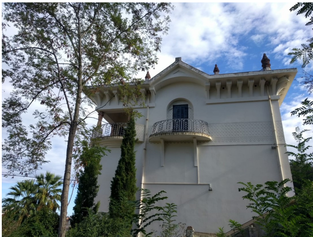
Vista de la façana lateral nord-oest
