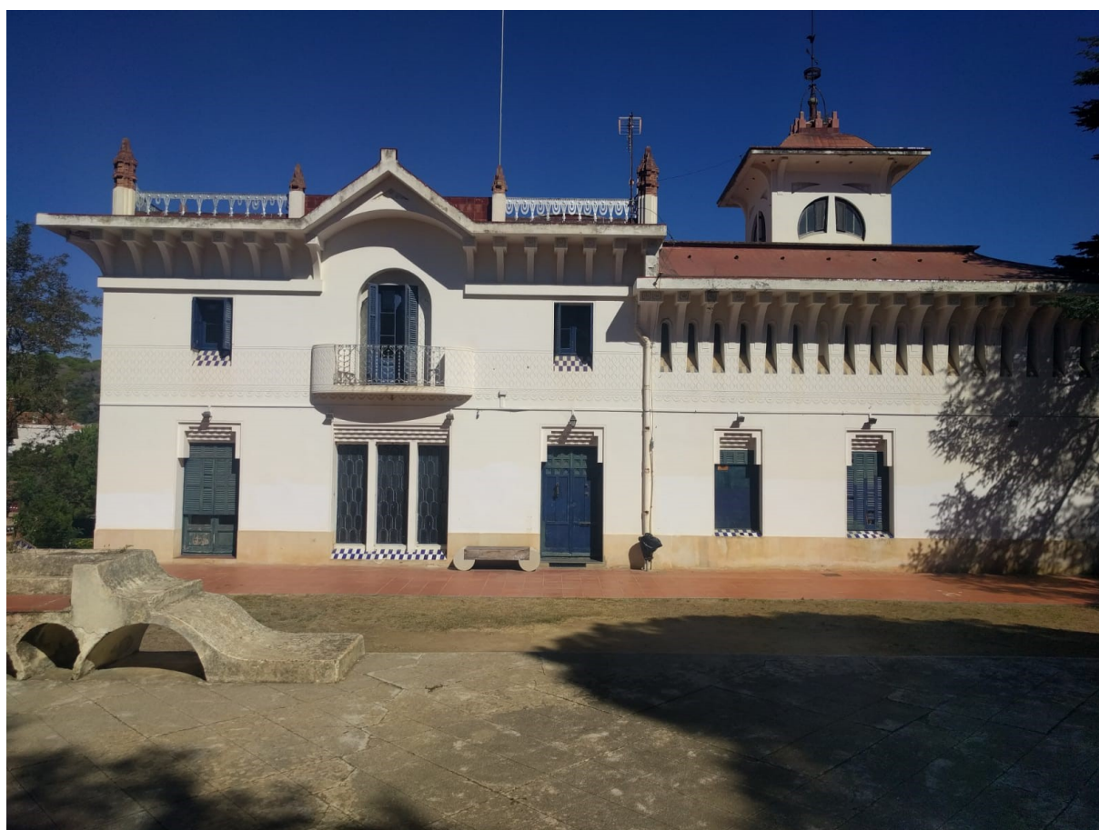
Vista de la façana lateral sud-oest
