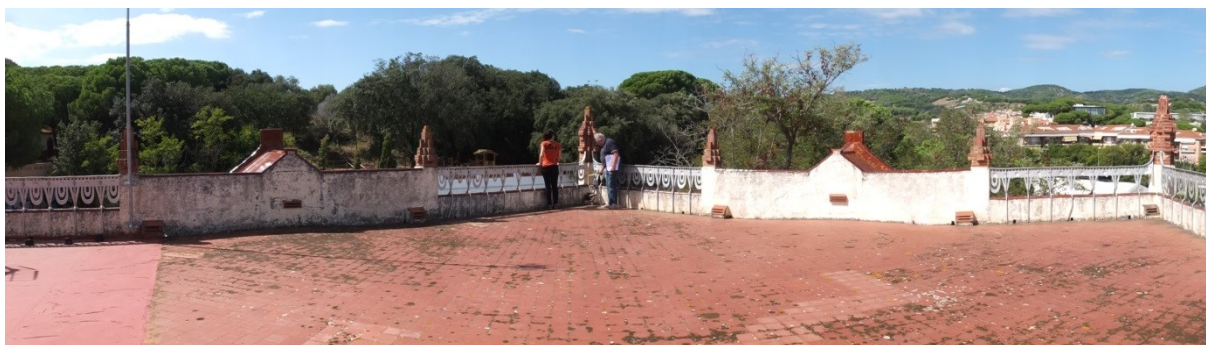
Imatges de les cobertes de l'edifici principal de Vil·la Flora. Font: GAA 25/09/2018
