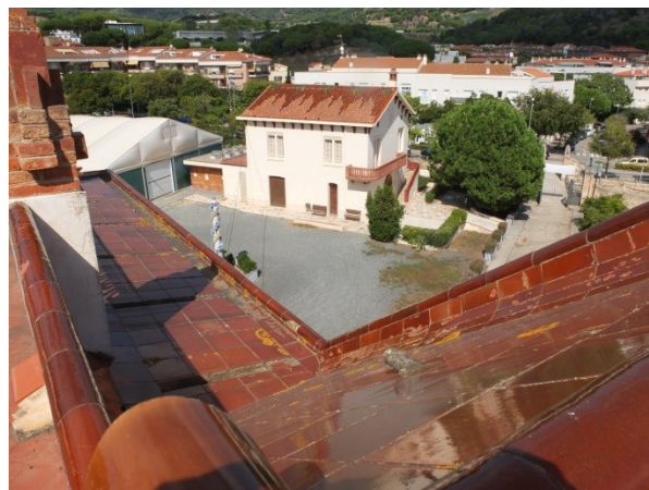
SECTOR B. Ràfec perimetral. Font: GAA 25/09/2018
