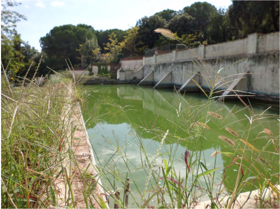
Imatge 2: estat actual de la bassa
