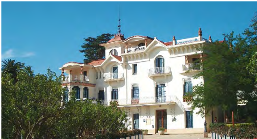
Imatge 1: Vista general de l'edifici
