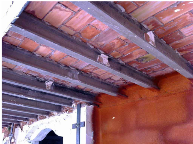
V07-08. Imatge de detall de l'espai cobert per la terrassa 3.3. S'observa part de la mitgera de llevant amb aïllament projectat. Font: Arxiu GAA. Data: 14/02/2014.
