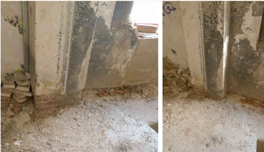
V04-05. Imatge de la base del pilar 03. S'observa la fonamentació executada, amb l'encepat ja formigonat. Pendent de revisió de l'existència i/o estat de tensors i armat segons projecte. Font: Arxiu GAA. Data: 14/02/2014.
