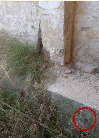
V10. Imatge de la base del pilar 07. S'observa que la fonamentació no està realitzada. Es veuen micropilotis amb l'armat corresponent i l'encofrat d l'encepat preparat per a formigonar (actualment sense formigonar). Font: Arxiu GAA. Data: 14/02/2014.
