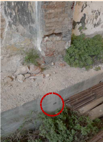
V14-15-16. Imatges de les fonamentacions 10, 11 i 12 executades, amb els encepats ja realitzats. S'observen alguns tensors realitzats. Pendent de revisió de l'existència i/o estat dels micropilotis i els tensors de l'encepat. Font: Arxiu GAA. Data: 14/02/2014.
