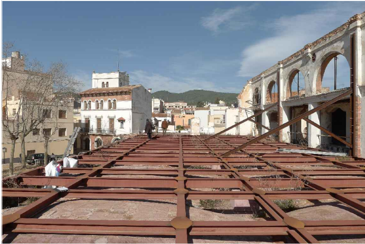
V03. Imatge global de la planta primera (espai 2.2). Estructura de suport del futur teatre. Mur de llevant apuntalat. Font: Arxiu GAA. Data: 14/02/2014.
