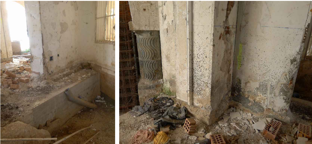
V01-02. Imatge de la base del pilar 13. S'observa la fonamentació executada, amb l'encepat ja formigonat. Pendent de revisió de l'existència i/o estat de tensors i armat segons projecte. Font: Arxiu GAA. Data: 14/02/2014.
