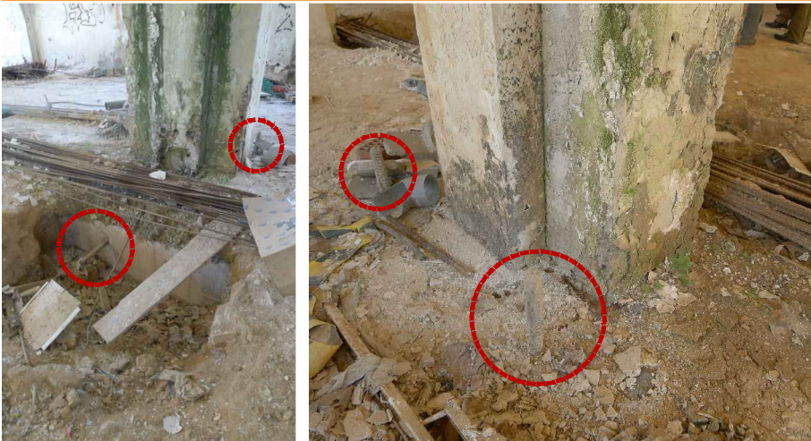
V08-09. Imatge de la base del pilar 17. S'observa la fonamentació executada, amb l'encepat ja formigonat, amb tensors (col·locats sense tensió). Font: Arxiu GAA. Data: 14/02/2014.
