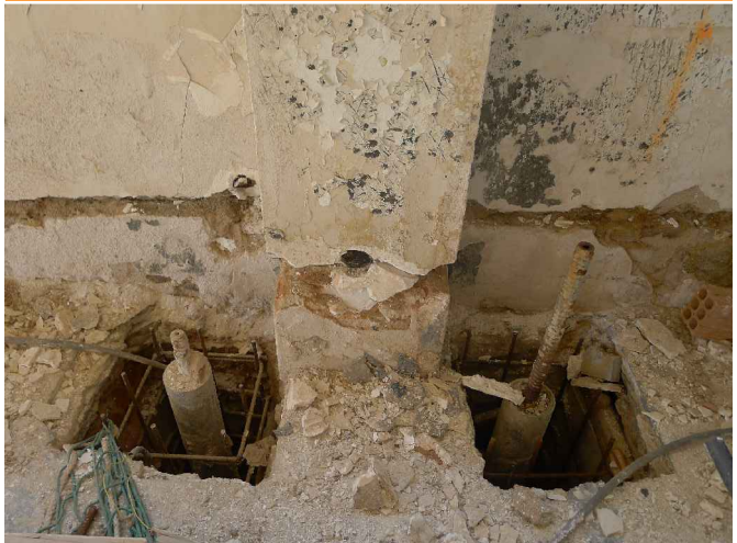
V10. Imatge de la base del pilar 07. S'observa que la fonamentació no està realitzada. Es veuen micropilotis amb l'armat corresponent i l'encofrat d l'encepat preparat per a formigonar (actualment sense formigonar). Font: Arxiu GAA. Data: 14/02/2014.
