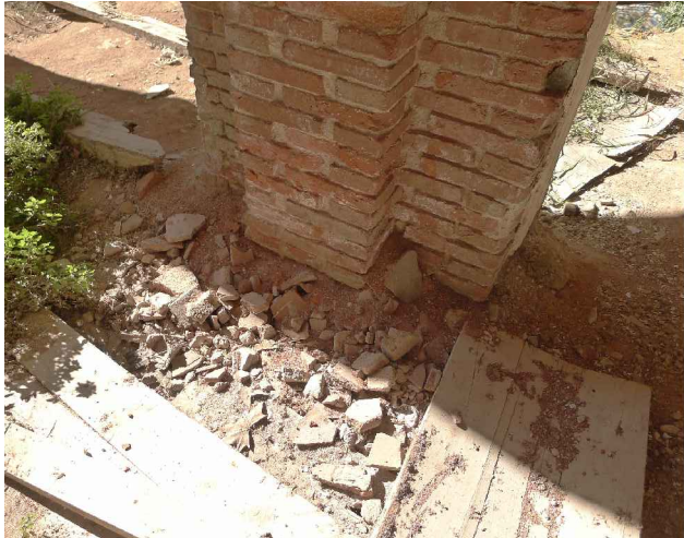
V03. Imatges de la base del pilar 31. Impossible observar l'existència o estat de la fonamentació existent. Font: Arxiu GAA. Data: 14/02/2014.
