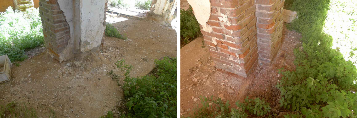
V01-02. Imatge de la base del pilar 30. S'observa la fonamentació executada, amb l'encepat ja formigonat. Pendent de revisió de l'existència i/o estat de tensors i armat segons projecte. Font: Arxiu GAA. Data: 14/02/2014.
