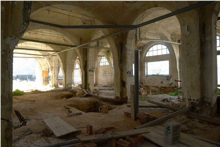
V04. Imatge de la porxada l'interior de l'edifici. S'observen algunes fonamentacions inacabades. També es poden veure algunes voltes de maó de pla atirantades. Font: Arxiu GAA. Data: 14/02/2014.
