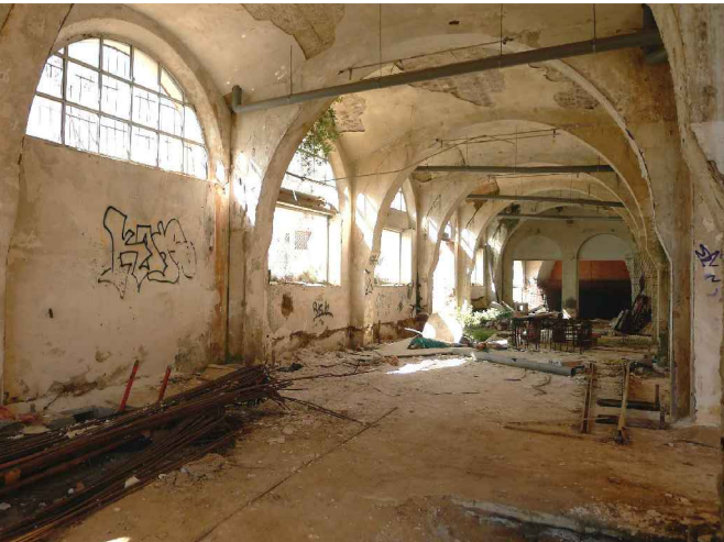
V13. Imatge de l'interior de la porxada de l'edifici. Canals i baixants provisionals d'evacuació de les aigües pluvials. Font: Arxiu GAA. Data: 14/02/2014.
