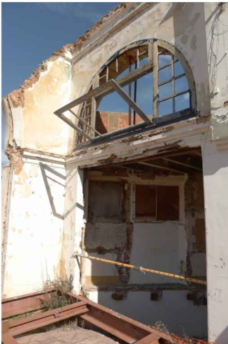
V09. Imatge de la cantonada entre la mitgera i la façana de tramuntana. Font: Arxiu GAA. Data: 14/02/2014.
