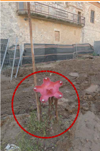
V20-21. Imatges de les fonamentacions 24 i 25 executades. Es veu l'armat, sobresortint. Pendent de revisió de l'existència i/o estat de tensors i armat segons projecte. Font: Arxiu GAA. Data: 14/02/2014.
