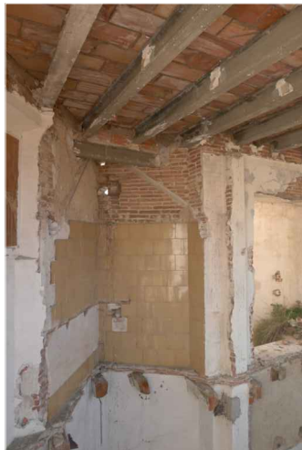
V07. Imatge de l'espai entre la mitgera de llevant i l'àmbit de la porxada (2.2). Font: Arxiu GAA. Data: 14/02/2014.
