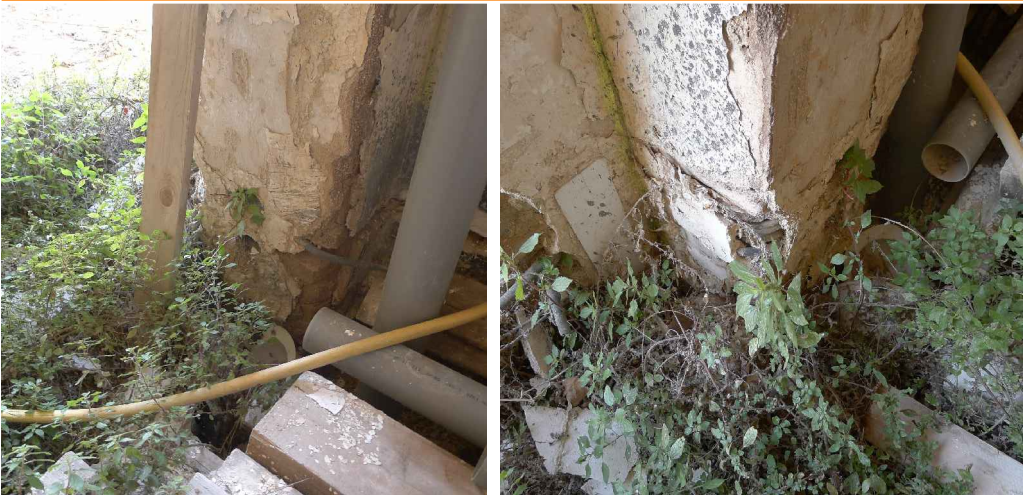
V07-08. Imatges de la base del pilar 05. Impossible observar l'existència o estat de la fonamentació existent. Font: Arxiu GAA. Data: 14/02/2014.
