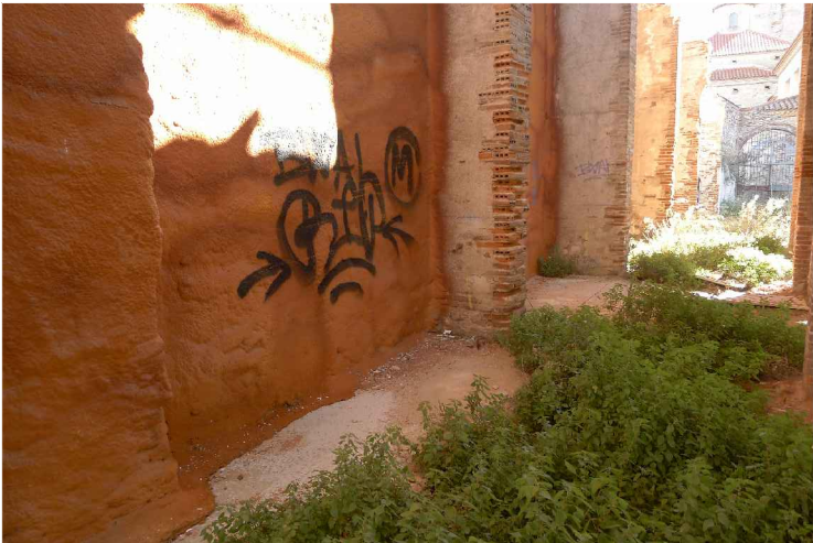
V10. Imatge de la mitgera de llevant, amb aïllament projectat. Espai 1.3. Font: Arxiu GAA. Data: 14/02/2014.
