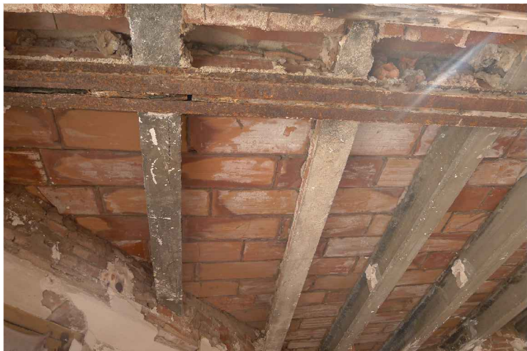
V10. Imatge de detall de la cantonada de l'espai cobert nord-est per la terrassa 3.1. S'observen les bigues prefabricades de formigó autoresistents i l'encadellat ceràmic. Font: Arxiu GAA. Data: 14/02/2014.
