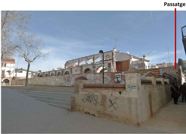
V02. Imatge de la façana de ponent. S'observa el paviment prefabricat de formigó realitzant durant les actuacions de l'any 2013. Font: Arxiu GAA. Data: 14/02/2014.
