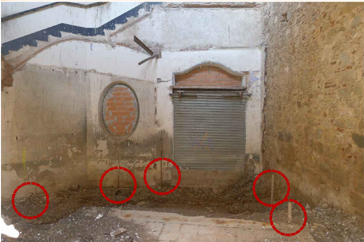
V10. Imatges de la base del mur (F36). S'observen els armats sobresortint dels micropilotis executats. Pendent de revisió de l'existència dels tensors de l'encepat. Font: Arxiu GAA. Data: 14/02/2014.
