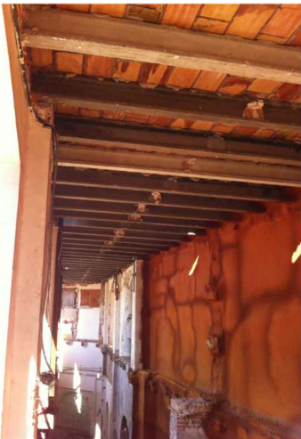
V07-08. Imatge de detall de l'espai cobert per la terrassa 3.3. S'observa part de la mitgera de llevant amb aïllament projectat. Font: Arxiu GAA. Data: 14/02/2014.
