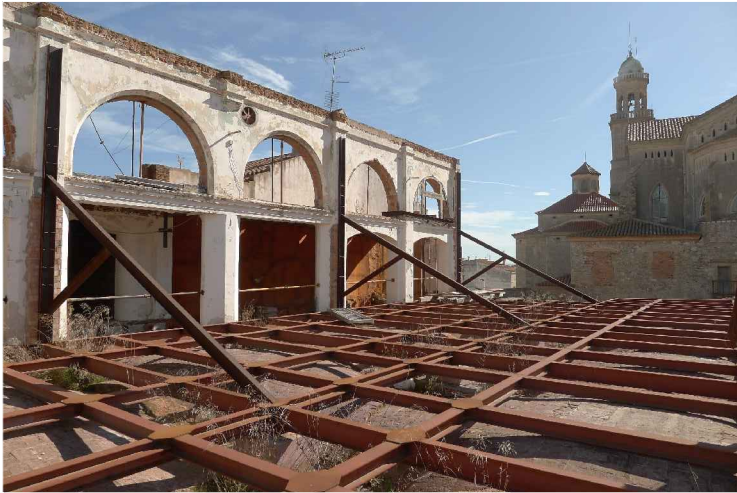
V02. Imatge global de la planta primera (espai 2.2), amb l'església parroquial de Sant Pere i Sant Pau al fons. S'observa mur estintolat amb tornapunts d'acer i l'estructura d'acer del sostre. Font: Arxiu GAA. Data: 14/02/2014.
