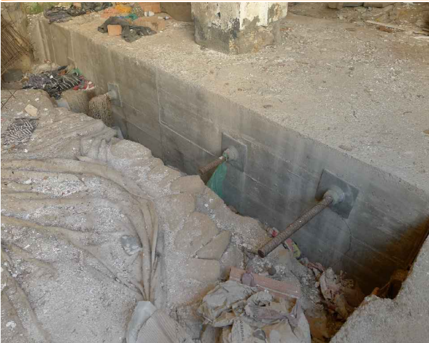
V03. Imatge de la fonamentació 02 realitzada (porxada, espai 1.1). S'observa l'encepat executat, amb tensors acabats. Font: Arxiu GAA. Data: 14/02/2014.
