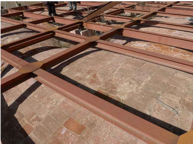
V04. Imatge d'un fragment de l'extradós de les voltes ceràmiques, i de la nova estructura d'acer exempta. Detall de l'extradós de les voltes. Font: Arxiu GAA. Data: 14/02/2014.
