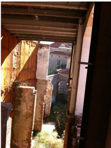
V11. Imatge de l'espai entre la mitgera i l'àmbit de la porxada. Font: Arxiu GAA. Data: 14/02/2014.
