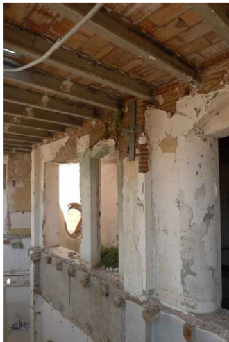
V05-06. Imatge de l'espai entre la mitgera de llevant i l'àmbit de la porxada, cobert amb bigues prefabricades de formigó armat, autoresistents i encadellat ceràmic (coberta 3.3). Font: Arxiu GAA. Data: 14/02/2014.
