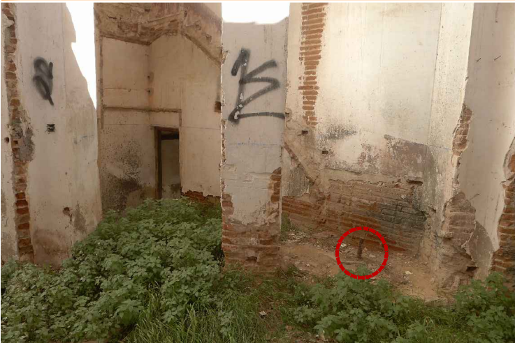
V09. Imatges de la base del mur (F35). S'observen els armats sobresortint dels micropilotis executats. Pendent de revisió de l'existència dels tensors de l'encepat. Font: Arxiu GAA. Data: 14/02/2014.
