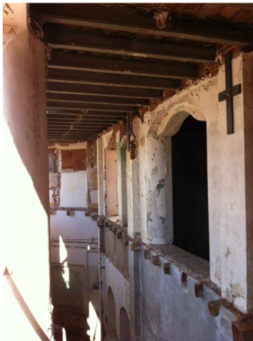
V05-06. Imatge de l'espai entre la mitgera de llevant i l'àmbit de la porxada, cobert amb bigues prefabricades de formigó armat, autoresistents i encadellat ceràmic (coberta 3.3). Font: Arxiu GAA. Data: 14/02/2014.
