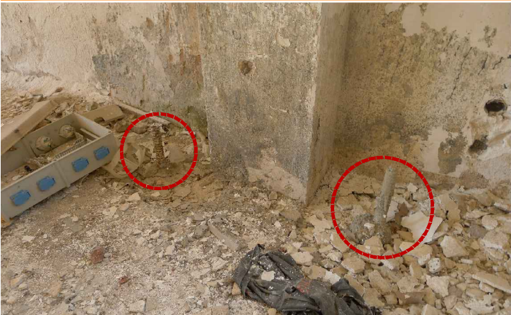
V11. Imatge de la fonamentació 08 executada, amb l'encepat ja realitzat. Es veuen els armats sobresortint dels micropilotis executats. Pendent de revisió de l'existència i/o estat dels tensors de l'encepat. Font: Arxiu GAA. Data: 14/02/2014.
