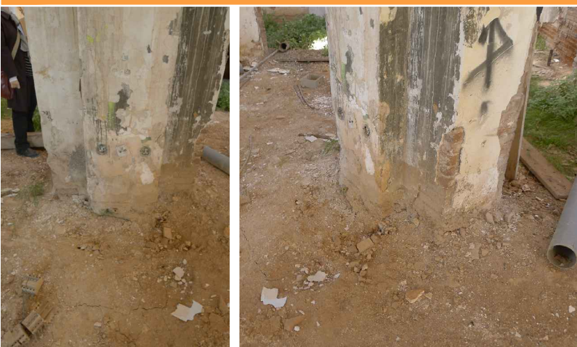
V25-26. Imatges de la base del pilar 28. Impossible observar l'existència o estat de la fonamentació existent. Font: Arxiu GAA. Data: 14/02/2014.
