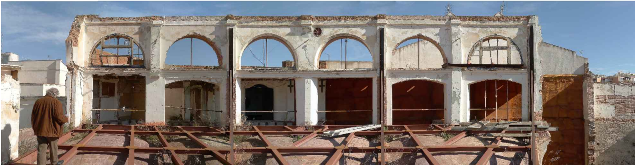
V03. Imatge de la façana interior de ponent. Font: Arxiu GAA. Data: 14/02/2014.
