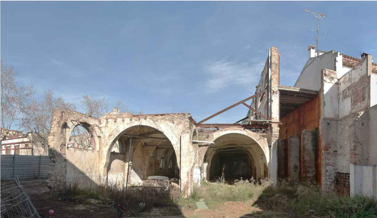
V02. Imatge de la façana sud del teatre Odèon. S'observa la volta esfondrada a primer pla. Mitgera de llevant amb aïllament projectat, parcialment. Font: Arxiu GAA. Data: 14/02/2014.
