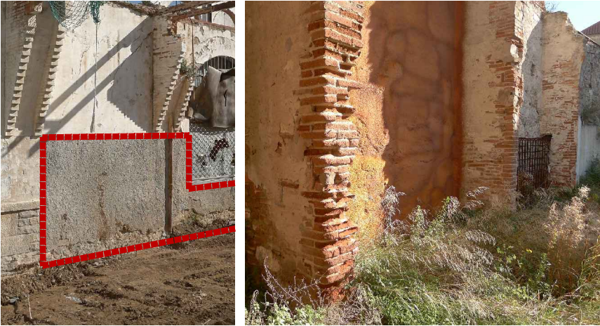
V11-12. Imatges dels revestiments de ciment Pòrtland (a la façana de ponent) i l'aïllament projectat a la mitgera de llevant, respectivament. Font: Arxiu GAA. Data: 14/02/2014.
