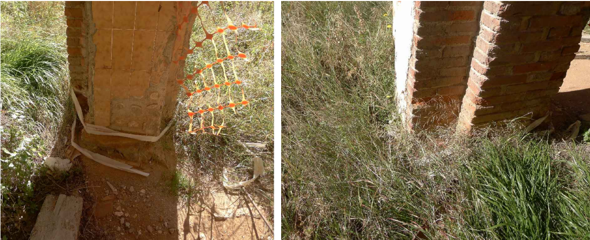
V04-05. Imatges de la base del pilar 32. Impossible observar l'existència o estat de la fonamentació existent. Font: Arxiu GAA. Data: 14/02/2014.
