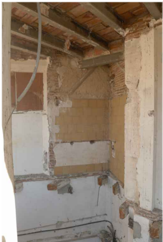
V08. Imatge de l'espai entre la mitgera de llevant i l'àmbit de la porxada (2.2). Font: Arxiu GAA. Data: 14/02/2014.
