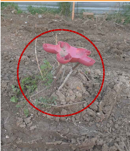
V20-21. Imatges de les fonamentacions 24 i 25 executades. Es veu l'armat, sobresortint. Pendent de revisió de l'existència i/o estat de tensors i armat segons projecte. Font: Arxiu GAA. Data: 14/02/2014.
