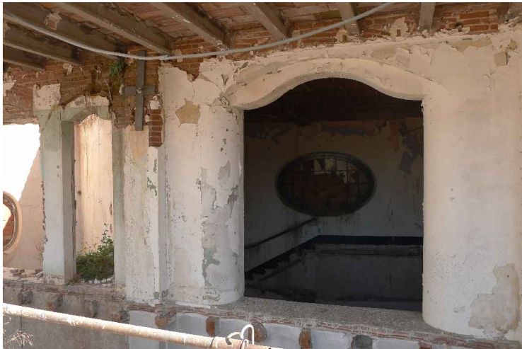
V10. Imatge de l'espai entre la mitgera de llevant i l'àmbit de la porxada (2.2). Sostre de biguetes autoresistents de formigó. Font: Arxiu GAA. Data: 14/02/2014.
