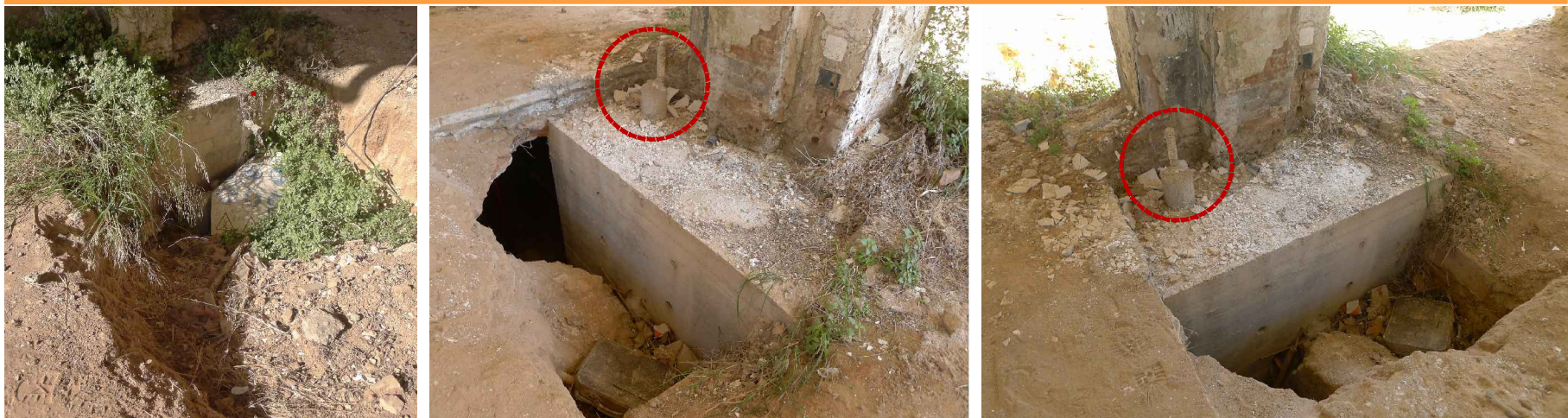
V12-13-14. Imatge de la base del pilar 19. S'observa la fonamentació executada, amb l'encepat ja formigonat. Es veuen els armats sobresortint dels micropilotis executats. Pendent de revisió de l'existència i/o estat de tensors i armat segons projecte. Accés a l'antiga bodega de la cooperativa. Font: Arxiu GAA. Data: 14/02/2014.
