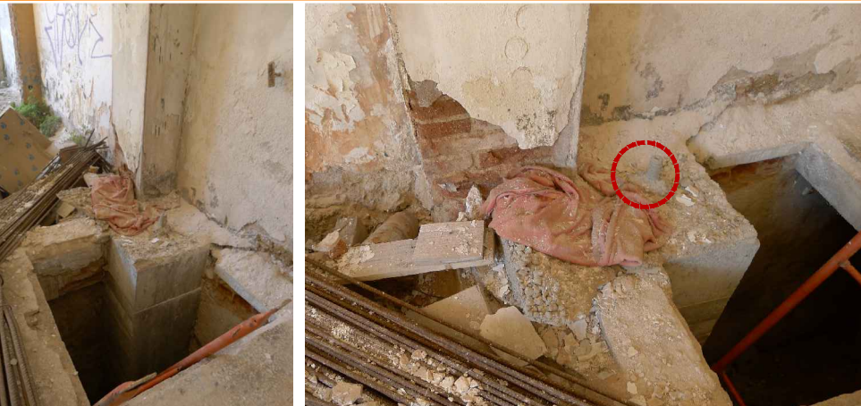
V12-13. Imatge de la fonamentació 09 executada, amb l'encepat ja realitzat. S'observen els armats sobresortint dels micropilotis executats. Pendent de revisió de l'existència dels tensors de l'encepat. Font: Arxiu GAA. Data: 14/02/2014.
