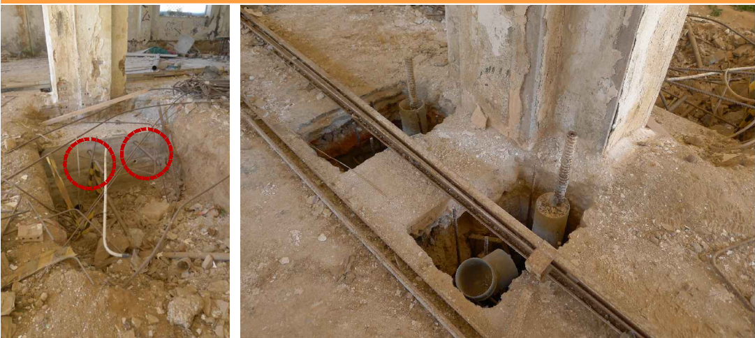
V10-11. Imatge de la fonamentació 18, no executada en un dels costats. Es veuen micropilotis amb l'armat corresponent i l'encofrat de l'encepat preparat per a formigonar (actualment sense formigonar). A l'altre costat s'observa l'encepat ja formigonat, amb tensors (col·locats sense tensió). Font: Arxiu GAA. Data: 14/02/2014.
