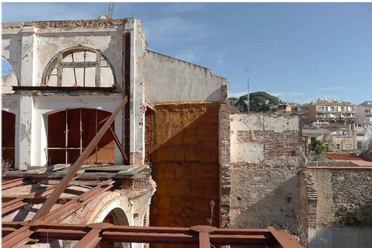
V05. Imatge d'un fragment de la mitgera de llevant. S'observa la crugia que falta per a completar les 16 voltes originals. Font: Arxiu GAA. Data: 14/02/2014.
