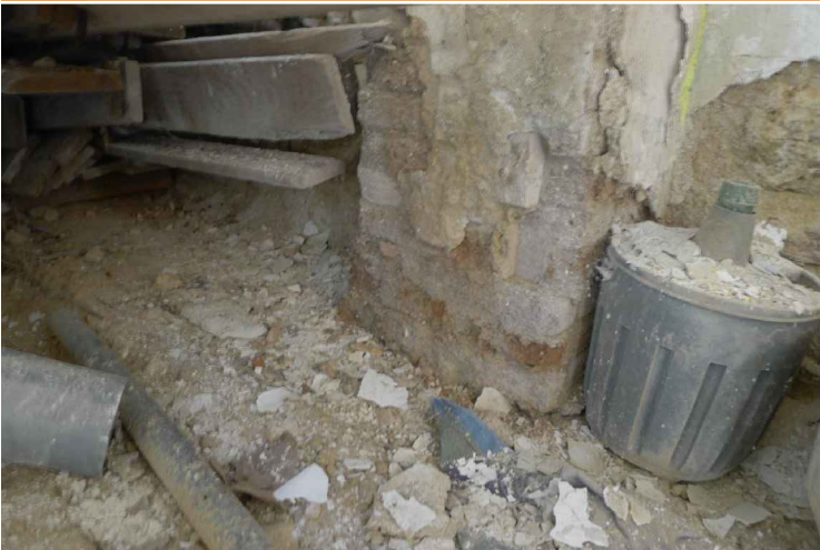
V06. Imatges de la base del pilar 04. S'observa la fonamentació executada, amb l'encepat ja formigonat. Pendent de revisió de l'existència i/o estat de tensors i armat segons projecte. Font: Arxiu GAA. Data: 14/02/2014.
