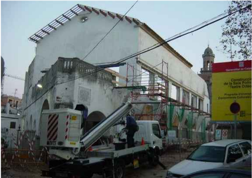
Estat de les obres. Font: Ajuntament Canet de Mar. Data: Novembre 2007.
