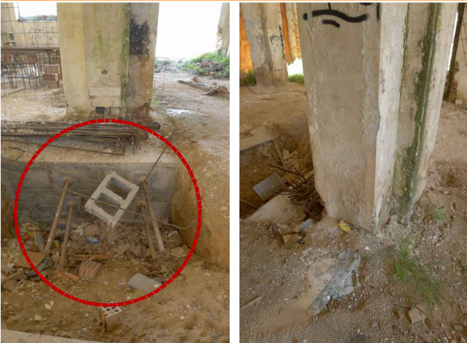
V06-07. Imatge de la base del pilar 16. S'observa la fonamentació executada, amb l'encepat ja formigonat, amb tensors (col·locats sense tensió). Font: Arxiu GAA. Data: 14/02/2014.
