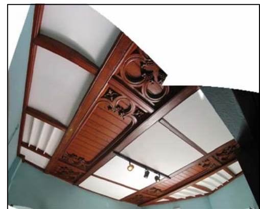
Forjat Tipus A. Sala 01
