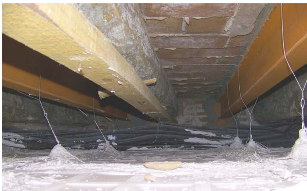
Figura 1.8: Observis la llata correctora de la geometria inferior de la bigueta per poder fixar el cel ras, s'observen els claus de cap gran típics per l'encanyissat
